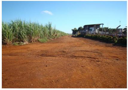
Figuras 252 e 253 - Revestimento com cascalho e inicio de processo erosivo.
