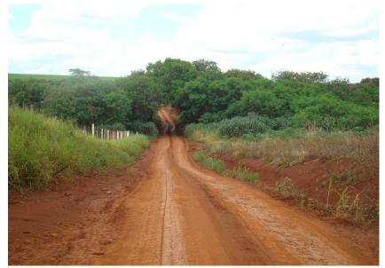
Figuras 194 e 195 - Processo erosivo na lateral da estrada
