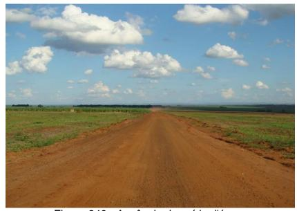
Figura 249 - Ausência de saída d'água.
