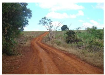
Figuras 162 e 163 - Processo erosivo no leito carroçável e trecho em aclive / declive.
