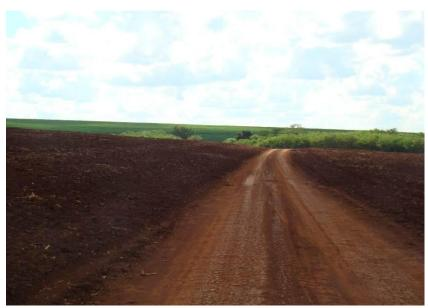
Figuras 220 e 221 - Trecho com costela de vaca e sem revestimento.
