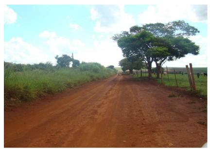
Figuras 91 e 92 - Trecho em aclive / declive com ausência de revestimento.
