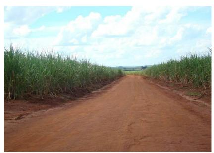
Figuras 218 e 219 - Ausência de sistema de drenagem.
