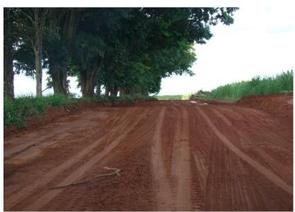
Figuras 242 e 243 - Ausência de revestimento.
