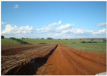
Figuras 122 e 123 - Ausência de sistema de drenagem.
