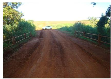
Figuras 125 e 126 - Ponte padrão defesa civil com guarda de corpo.
