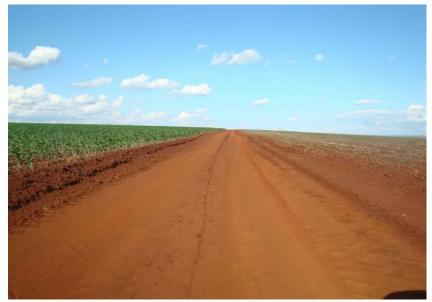
Figuras 112 e 113 - Ausência de revestimento.
