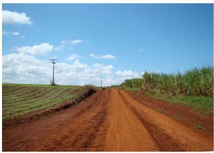
Figuras 53 e 54 - Trecho com revestimento mal distribuído / compactado e processo erosivo no leito carroçável.
