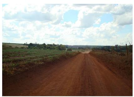
Figuras 222 e 223 - Trecho em aclive / declive com ausência de saída d'água.
