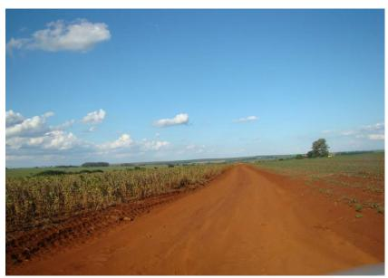
Figuras 120 e 121 - Barranco e plataforma não conformada.
