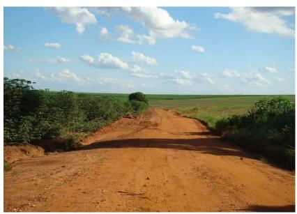
Figuras 245 e 246 - Plataforma não conformada e processo erosivo na lateral da estrada.
