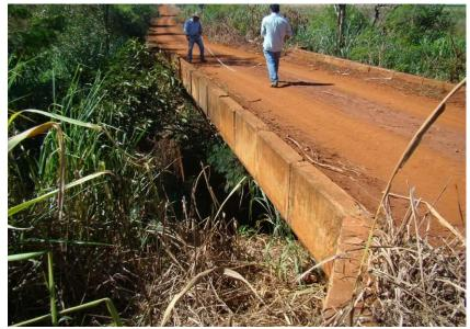
Figuras 278 e 279 - Ponte sem guarda corpo em estrutura de concreto.
