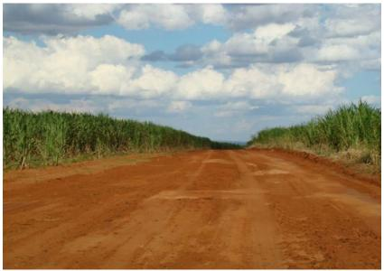
Figura 244 - Trecho sem saída d'água e sistema de drenagem.
