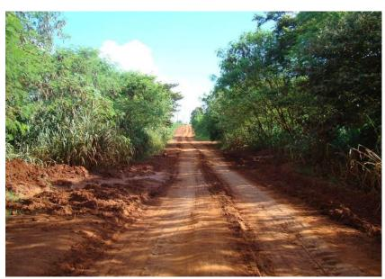
Figuras 234 e 235 - Ausência de saída d'água e atoleiros.
