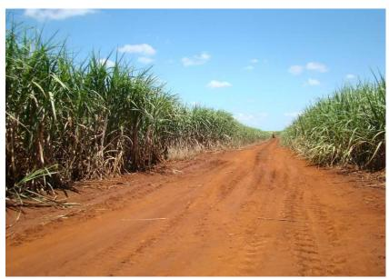
Figuras 47 e 48 - Ausência de saída d'água.
