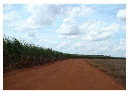
Figuras 196 e 197 - Ausência de sistema de drenagem.
