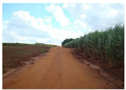
Figuras 212 e 213 - Trecho estreito e processo erosivo na lateral da estrada.
