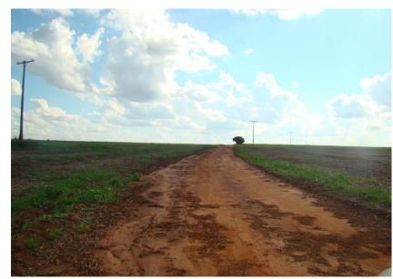
Figuras 105 e 106 - Ausência de saída d'água e de revestimento.
