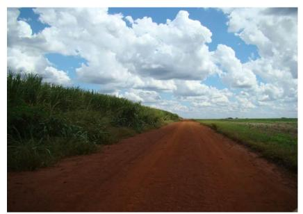
Figuras 309 e 310 - Ausência de sistema de drenagem.
