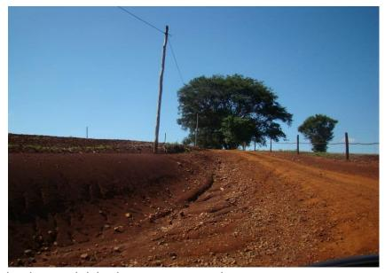
Figuras 266 e 267- Final da estrada e trecho encaixado com inicio de processo erosivo.
