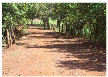
Figuras 22 e 23 - Trecho com ausência de saída d'água e plataforma não conformada.
