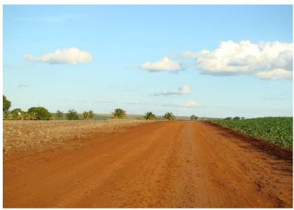
Figuras 127 e 128 - Costela de vaca e ausência de revestimento.
