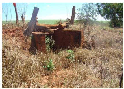
Figuras 299 e 300 - Canaleta natural na lateral da estrada e passagem de gado sob a estrada.
