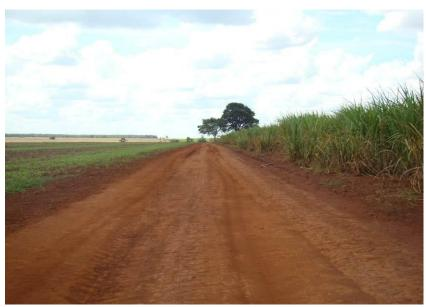
Figuras 160 e 161 - Trilho de roda e plataforma não conformada.
