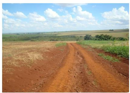
Figura 71 - Processo erosivo no leito carroçável.
