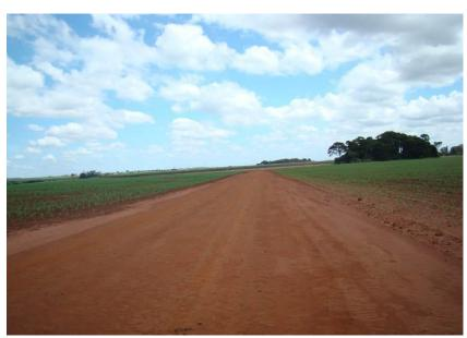
Figuras 145 e 146 - Ausência de sistema de drenagem.
