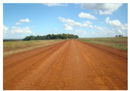
Figuras 100 e 101 - Plataforma conformada porém sem revestimento.
