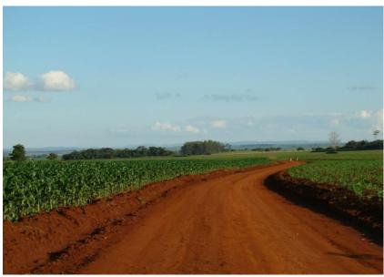
Figuras 141 e 142 - Ausência de saída d'água.
