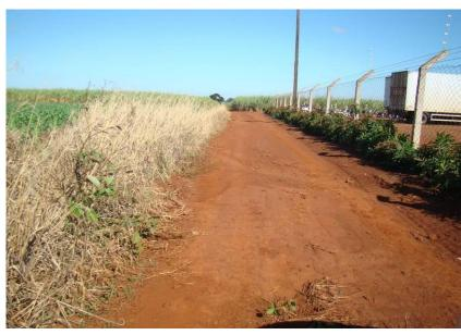
Figuras 258 e 259 - Presença de cerca impossibilitando a passagem e trecho com processo erosivo na estrada.
