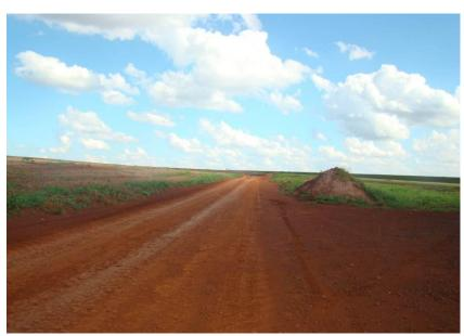
Figuras 98 e 99 - Ausência de saída d'água.
