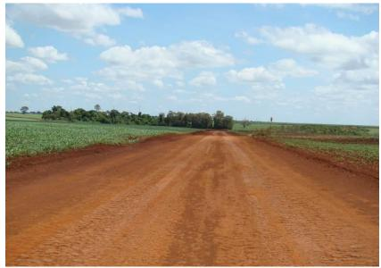
Figura 151 - Ausência de revestimento.
