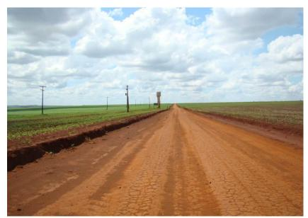
Figuras 59 e 60 - Trecho encaixado entre barrancos de 0,3 metros.
