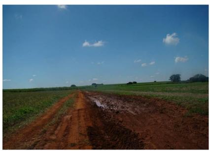
Figuras 287 e 288 - Revestimento com seixo rolado e atoleiro.
